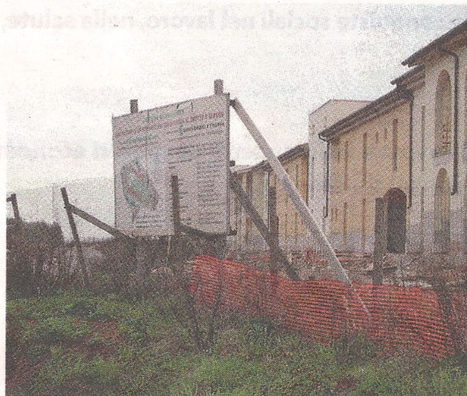
Il cantiere del Consorzio Etruria all'ippodromo di Follonica
